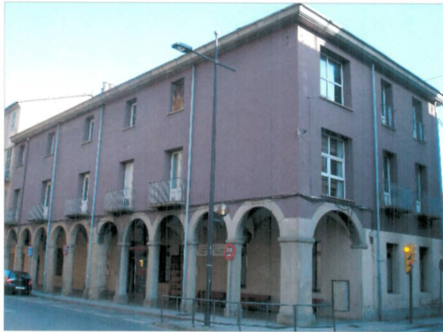
Edifici antics jutjats d'Olot
