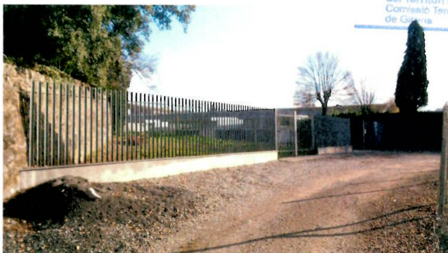
Final de la Ronda del Xiprer: La tanca única amb els 2 accessos Al pas privat de 4 mts. del Mas Subiràs, i al recinte Escolar de l'Institut
