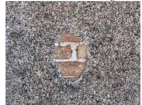
Gredera natural i arrebossat amb greda.
