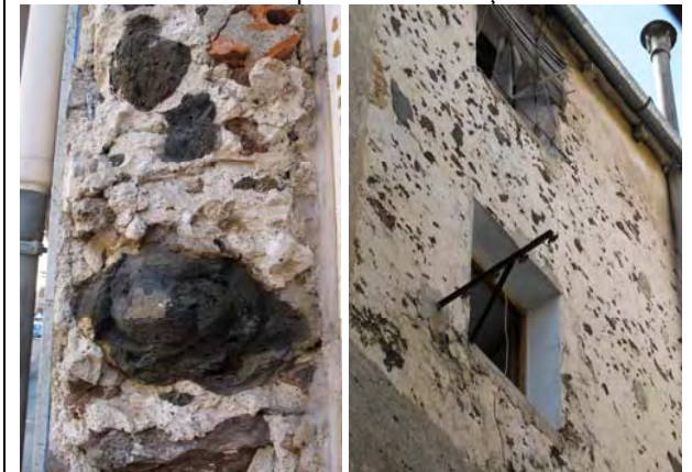
Paredat de bolos volcànics en mur i façana.
