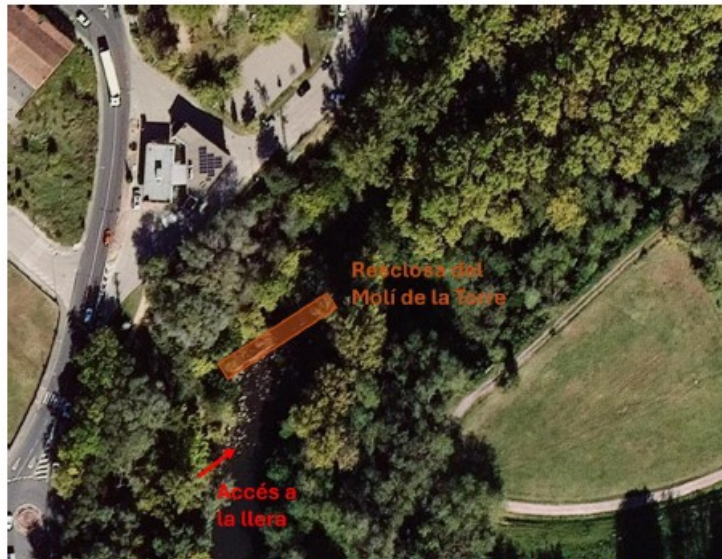
Figura 4. Zona d'accés a la llera en el marge esquerre del riu, a les proximitats de la resclosa del Molí de la Torre
